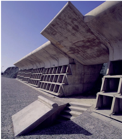
Fig.62 Cimetière d'Igualada. Vue rapprochée des niches en béton intégrées au terrain [Photographie]. Arquitectura Viva. https://arquitecturaviva.com/works/cementerio-igualada
