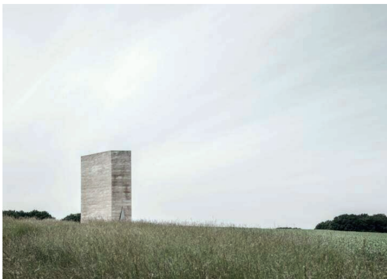
Fig.63 Chapelle Bruder Klaus (Feldkapelle), Mechernich-Wachendorf (Allemagne). Vue extérieure monolithique en béton [Photographie]. Global Spaces. Projet de Peter Zumthor (2005-2007). https://globalspaces.eu/2024/06/24/bruder-klaus-feldkapelle/
